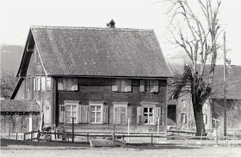
Das alte Schulhaus an der Schweizer Straße
